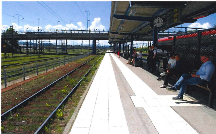
Figur 49: Ledstråk på tågplattformen och varningsplattor för sittbänken.
