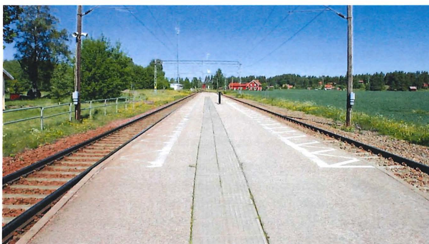
Figur 35: Det finns taktila plattor längs mitten på perrongen men de saknar kontrast mot omgivningen. Kupolplattor saknas på perrongens kant vid varje spår.
