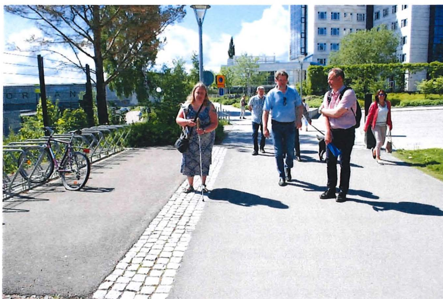
Figur 45: avsaknad av ledstråk på vägen till Vasaparkens hållplatser. På bilden syns kantstenar som är till för att rama in cykelparkeringen.
